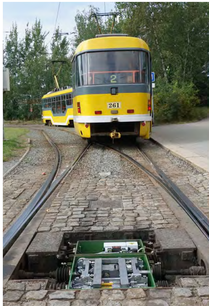
Auch in Pilsen kommt das Steuerungssystem von Elektroline zum Einsatz.
