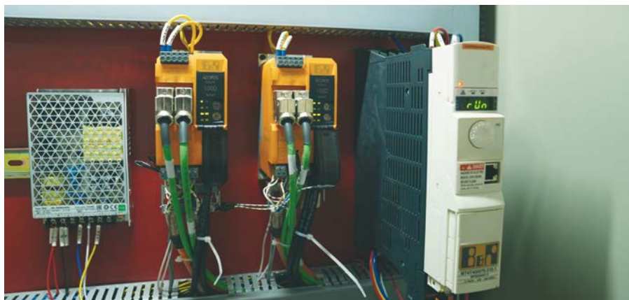
Der integrierte Ansatz von B&R ermöglicht es, Servoantriebe, Stepper und Frequenzumrichter in einem einzigen Netzwerk zu synchronisieren.
