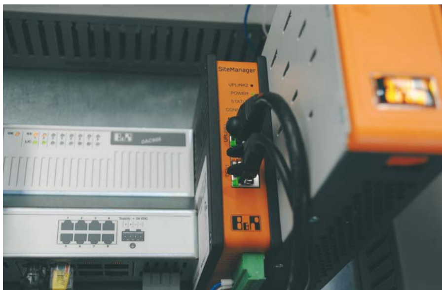
Der SiteManager ist ein kleines, sicheres und internetfähiges Modem, das die Maschine über die installierte Steuerung mit dem Internet und dem GateManager-Server verbindet.
