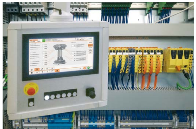
Der Nothalt-Taster ist über ein Nothalt-Bedienpult auf die Sicherheitssteuerung verlinkt.
