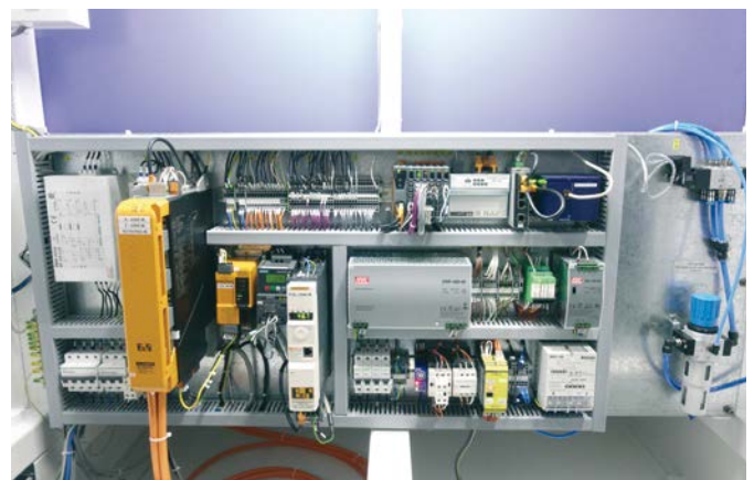
Der Einsatz von ACOPOS P3-Servoantrieben reduziert den Platzbedarf im Schaltschrank um rund 69%.
