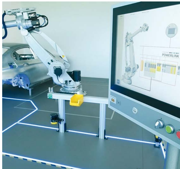
Leuchtbänder im Boden markieren die Sicherheitsbereiche und signalisieren den Zutritt.
