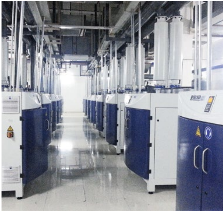
Diese zentrale Luftversorgungsanlage stellt für mehrere Produktionslinien Vakuum und Blasluft energieeffizient zur Verfügung.
